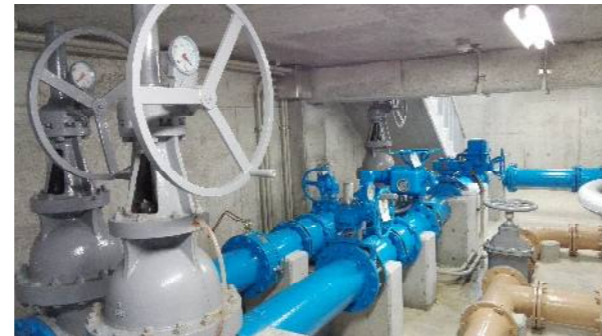
発電機設置予定場所
