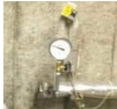
圧力調査 (アナログ式圧力計)
