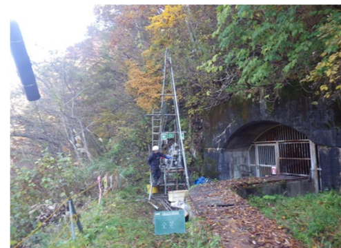
図-2 地質調査状況
