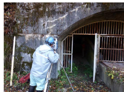
図-3 測量実施状況
