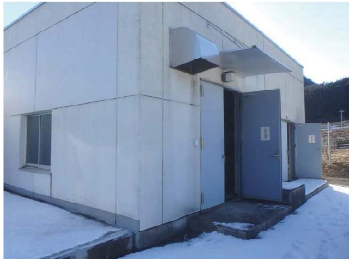
写真1 第一減圧施設外観
