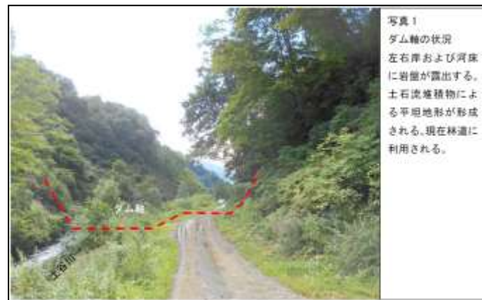
取水ダム地点
