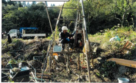
地形測量作業中
