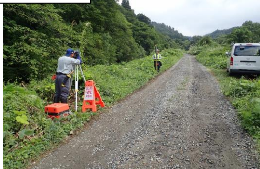
地形測量作業中
