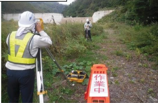
地形測量作業中
