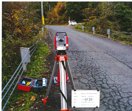
地形測量状況
