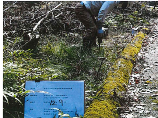
地質調査状況
