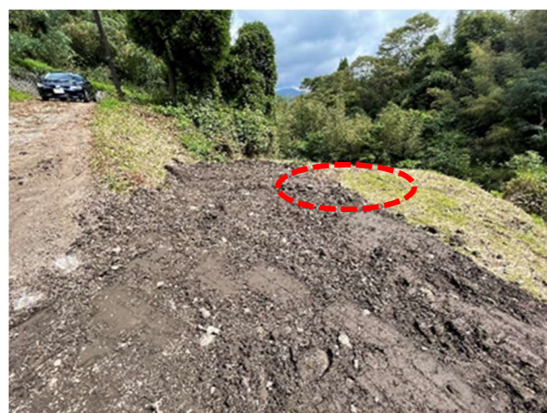
発電所建屋予定地点
