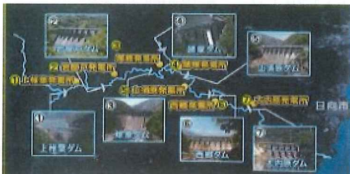
耳川水系の水力発電所
