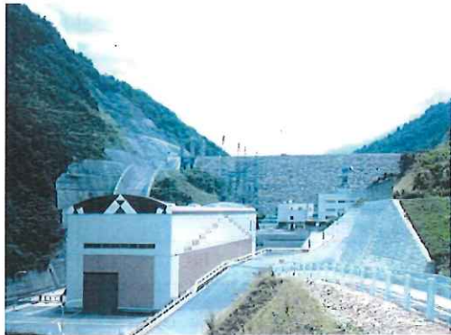
二居ダムと発電所（奥清津）
