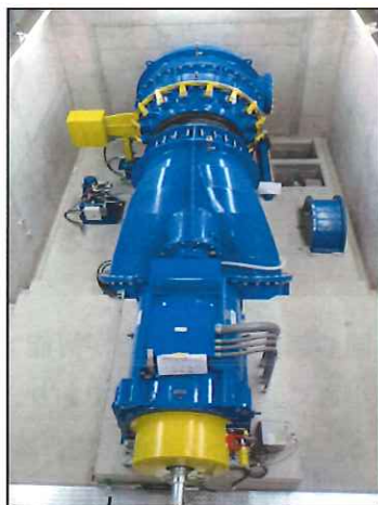
S型チューブラ水車（プロペラ水車）
