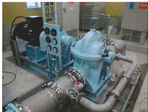
ポンプ逆転水車
