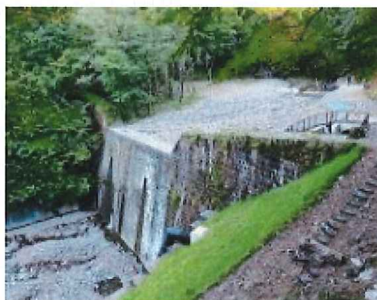
東鴉川発電所の取水に利用した既設砂防堰堤
