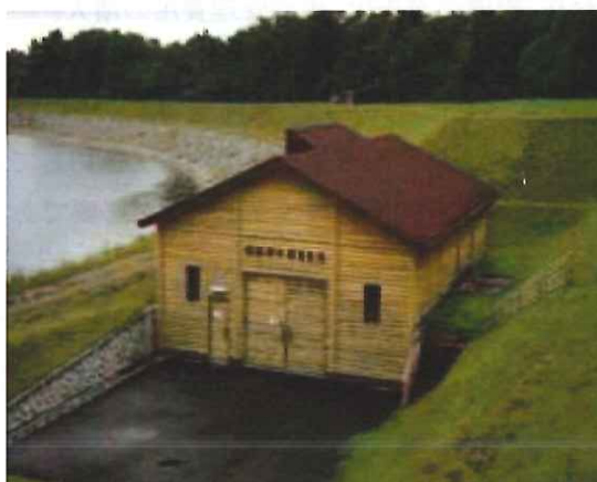
那須野ヶ原発電所の建屋
