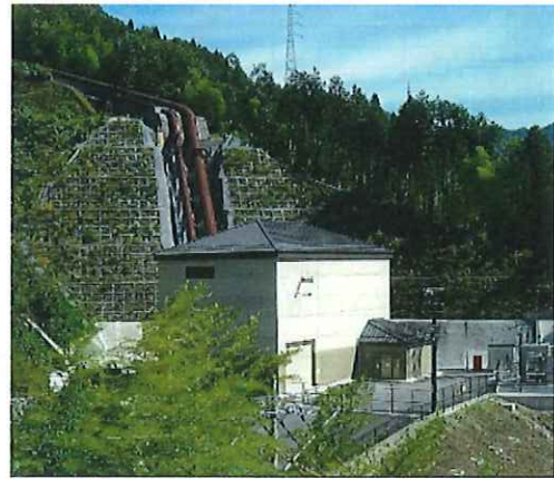
発電所修景（奥津第二）
