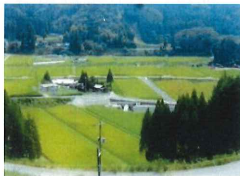
導水管埋設後(埋戻し後)
