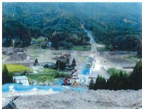
導水管埋設前(掘削状況)
