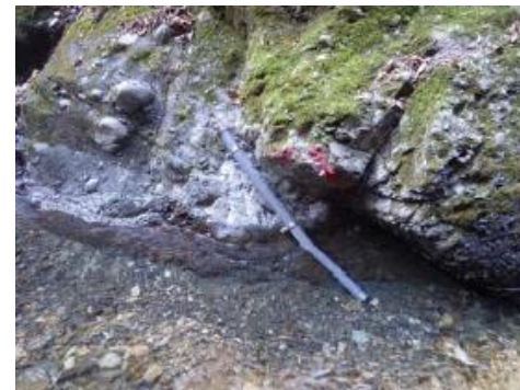
水位計設置状況
