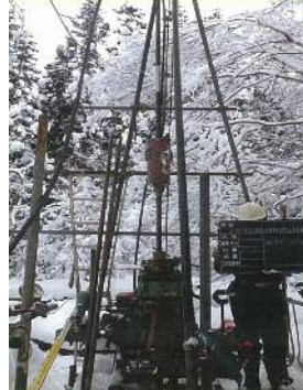
地質調査状況
