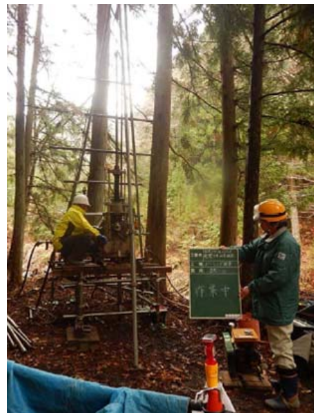
地質測量(ボーリング調査)
