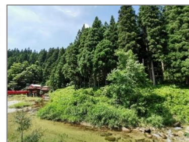
発電所地点の状況
