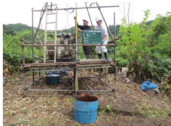
地質調査状況(水槽予定地点)
