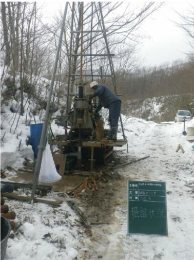
地質調査作業中
