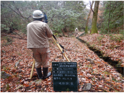
地形測量状況
