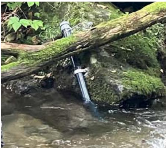
絶対圧水位計設置状況
