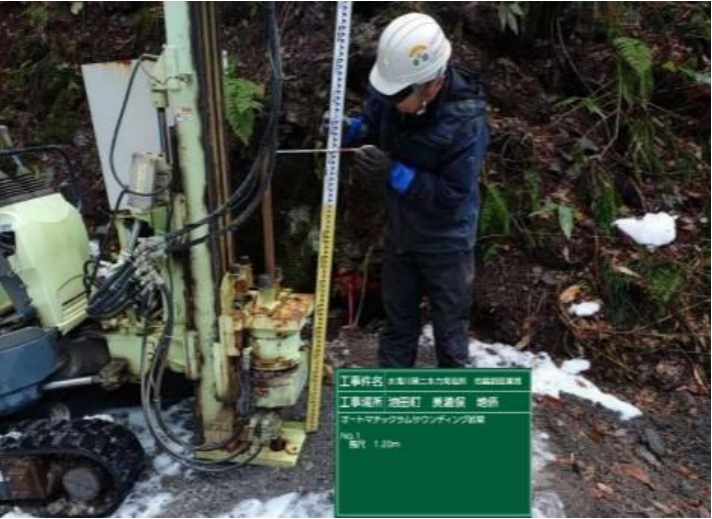
地質調査の様子
