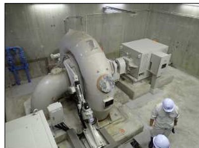
水車発電機基礎調査
