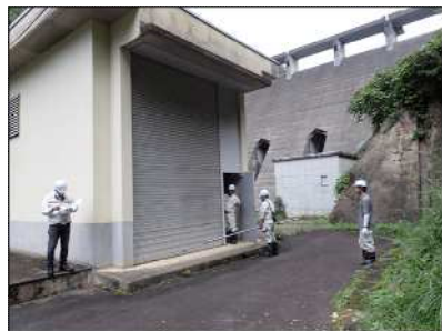
発電所入口、搬入口の確認
