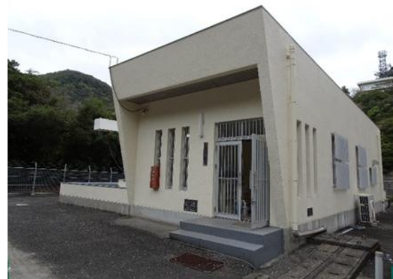
発電所建屋外観（地上部）
