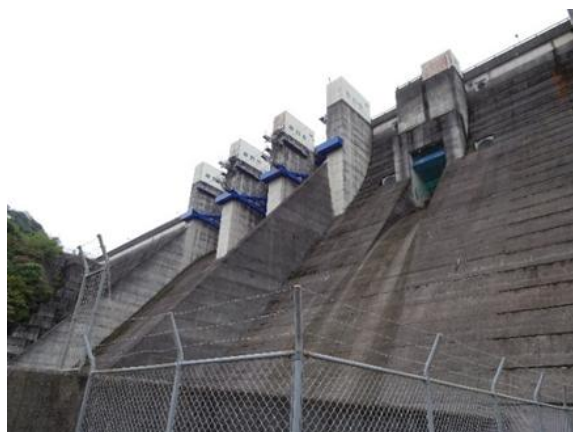
取水設備（耶馬溪ダム）
