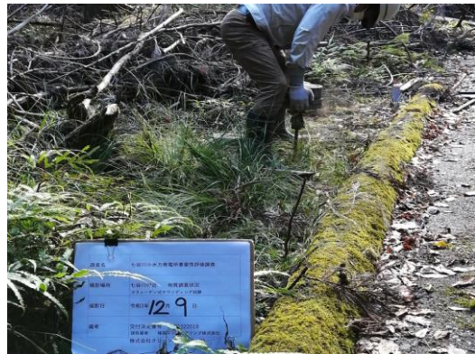
地質調査状況
