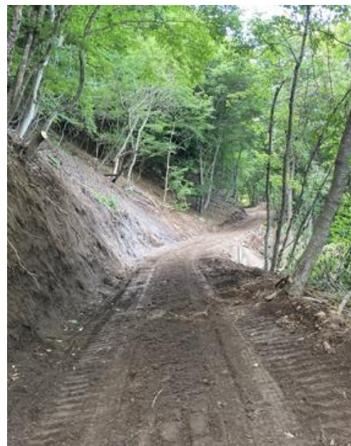
作業道整備状況
