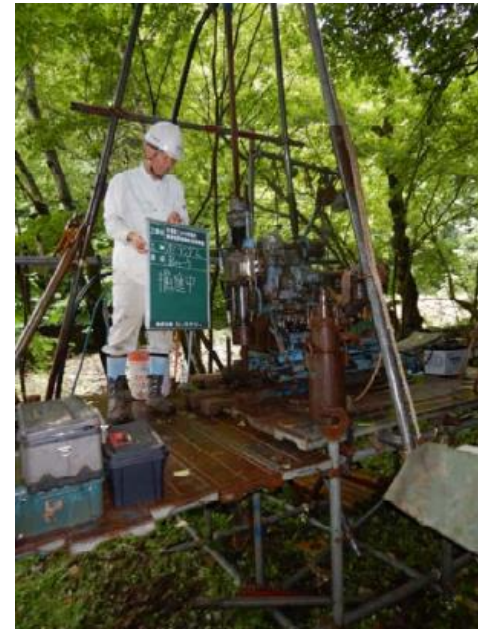
ボーリング調査状況
