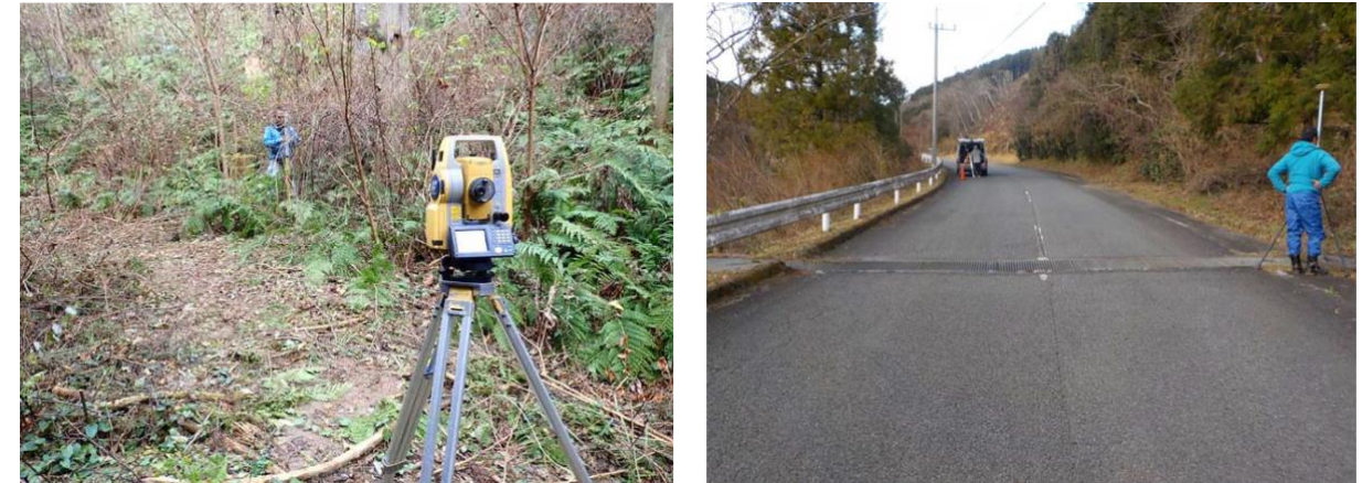
写真3 測量作業状況
