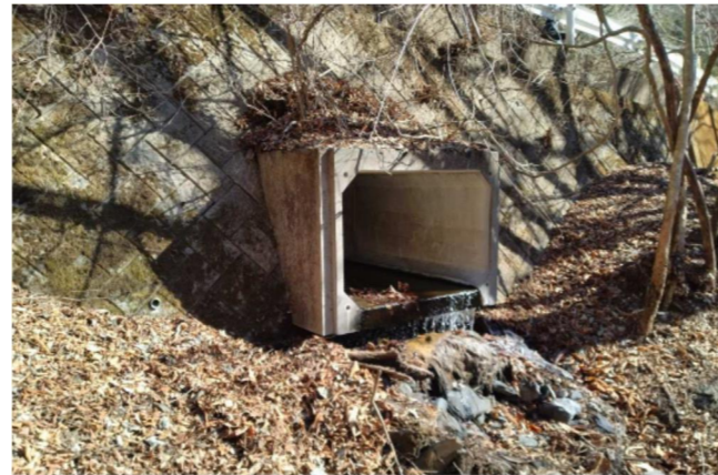
既存構造物(ボックスカルバート)
