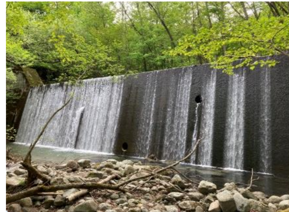
取水予定地点の堰堤(既存施設調査対象)
