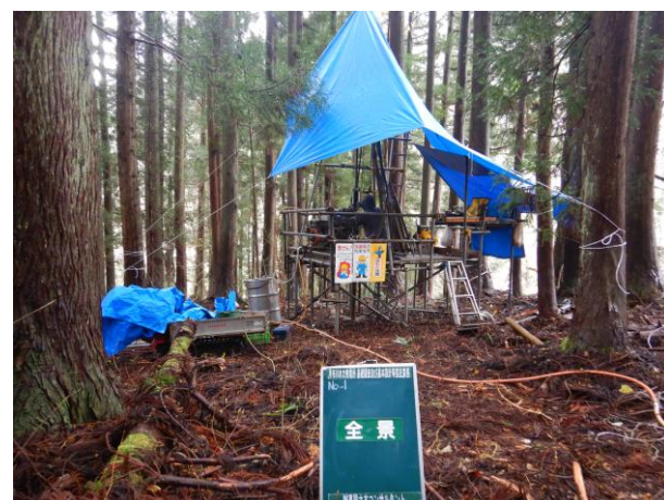
ボーリング調査
