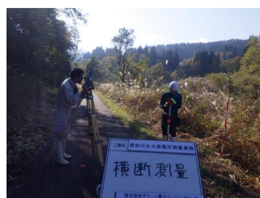
写真4 河川横断測量の様子
