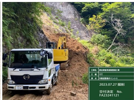
作業道整備の様子(令和5年度)
