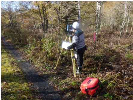
水圧管路敷設部の間接水準測量
