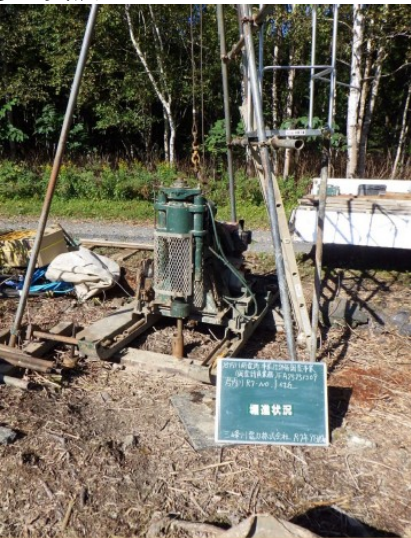
水圧管路敷設部のボーリング調査
