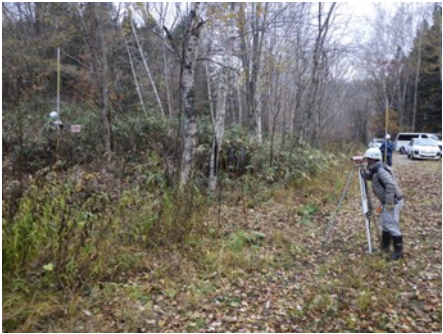
水圧管路敷設部の直接水準測量
