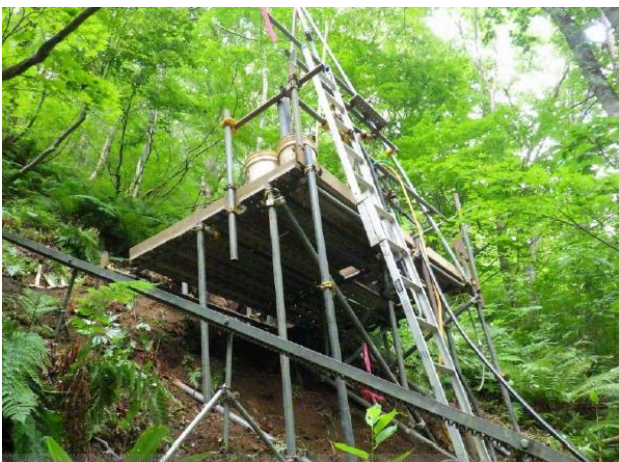
ボーリング調査
