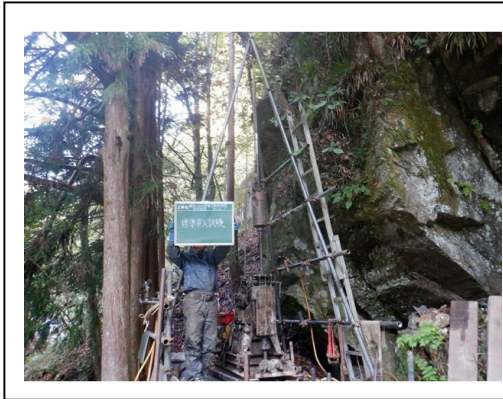
地点 No.1 ボーリング調査
