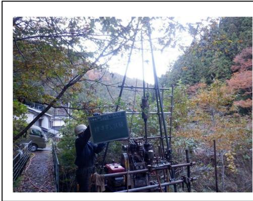
地点 No.2 ボーリング調査
