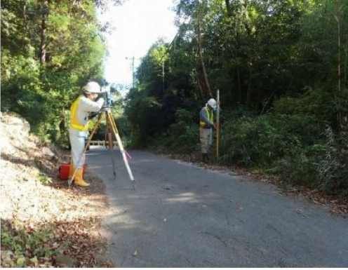
写真4:地形測量(基準点測量)
