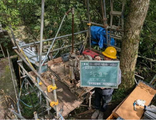
写真2:地質調査(取水口)
