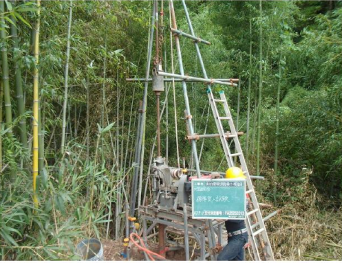
写真1:地質調査(発電所)
