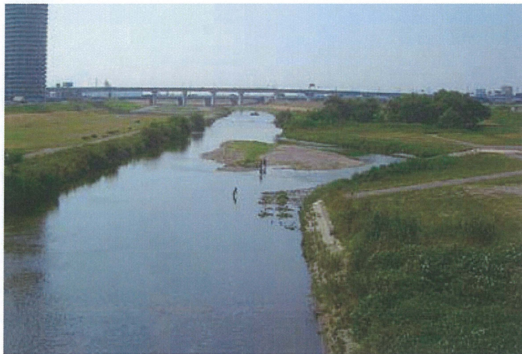
写真 2-2-1 工法導入後半年が経過した施工地（ワンド造成区）の様子
