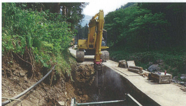
写真3-3-5 ブレイカー掘削機を使った掘削状況
