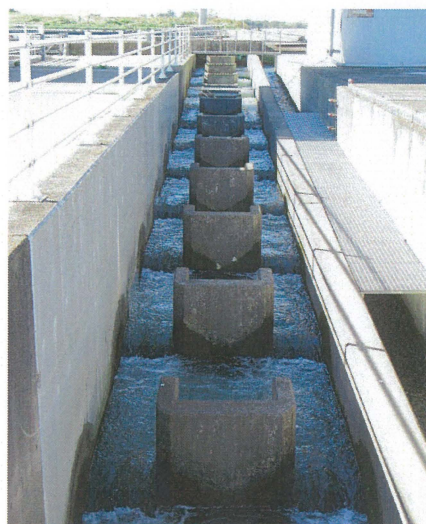
写真 2-4-6 利根大堰（水資源機構） （アイスハーバー型魚道）
