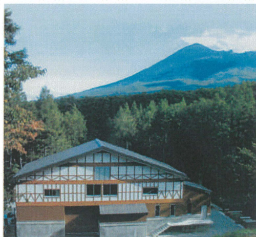
写真 5-4-1 柏台発電所（岩手県）
