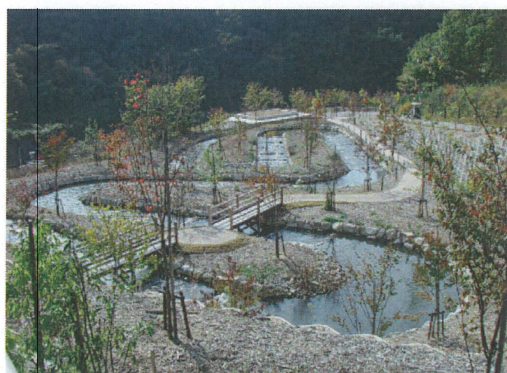
写真 2-4-1 上流部魚道全景
