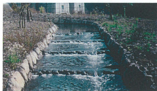
写真 2-4-2 隔壁・側壁の粗石張
