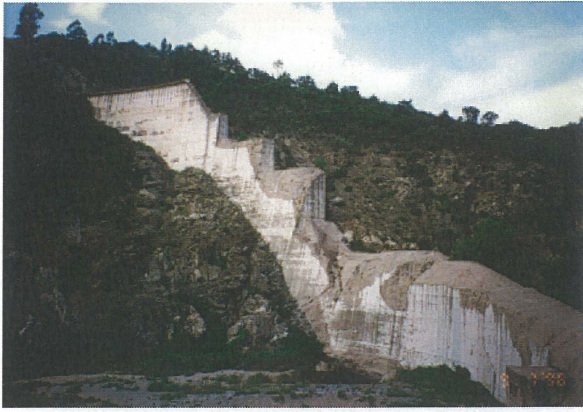
写真 4-4-1 マルパッセダムの下流河床～右岸側の状況
