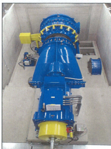
写真7-2-5 S型チューブラ水車（プロペラ水車）
