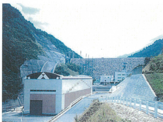
二居ダムと発電所（奥清津）
