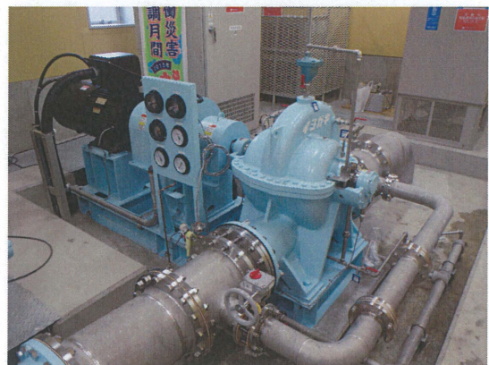
写真7-2-4 ポンプ逆転水車
